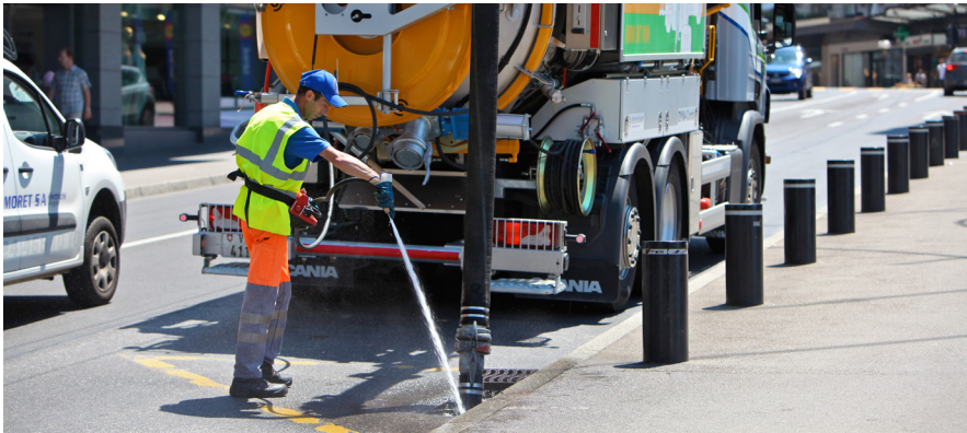
Curage de canalisations pour une commune qui soigne ses espaces publics.
